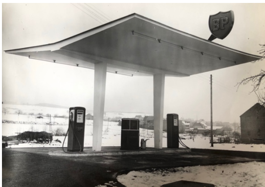
Abb. 2 BP-Typentankstelle Freiburg, 1952, mit sichtbarem Unterzug (saai Karlsruhe)
